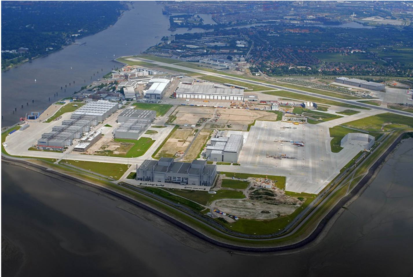
Werkserweiterung Mühlenberger Loch ( https://perma.cc/J4L7-R5G7 )
